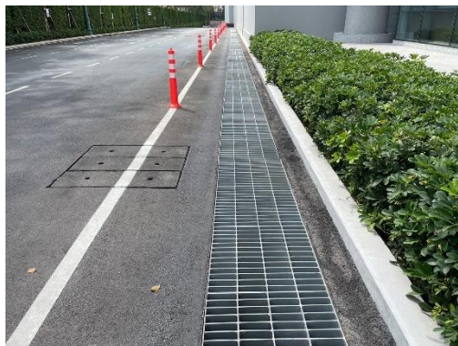
รูปที่ 2-46 ตะแกรงปิดรางระบายน้ำ
