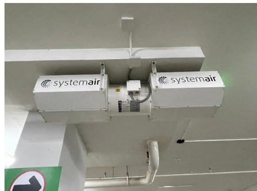
รูปที่ 2-5 พัดลมดูดอากาศบริเวณชั้นใต้ดิน B1-B2
