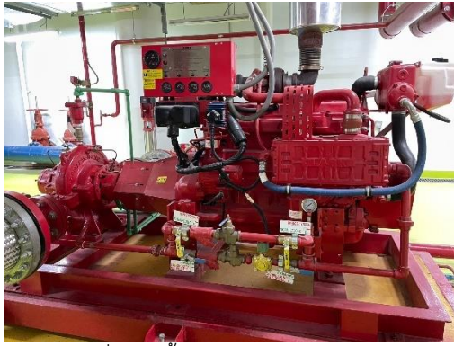
เครื่องสูบน้ำดับเพลิง (Fire Pump)
