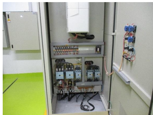
รูปที่ 2-25 อุปกรณ์ปรับความเร็วรอบมอเตอร์ (VSD)
