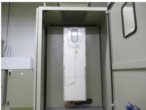
รูปที่ 2-25 อุปกรณ์ปรับความเร็วรอบมอเตอร์ (VSD)
