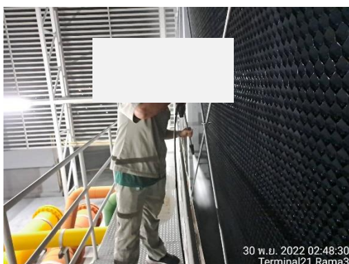
รูปที่ 2-34 การทำความสะอาด Cooling Tower
