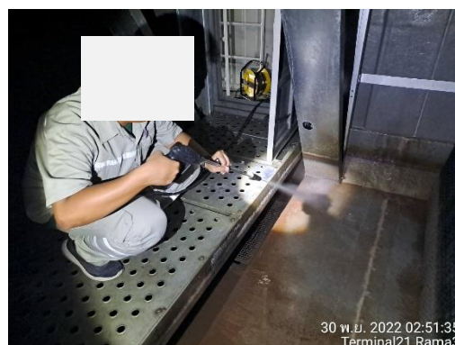
รูปที่ 2-34 การทำความสะอาด Cooling Tower
