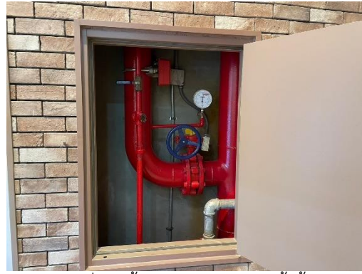
ระบบท่อเย็นเพื่อรับน้ำดับเพลิงจากถังเก็บน้ำชั้นใต้ดิน B2
